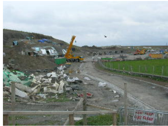
Baustelle des Besucherzentrums an den Cliffs of Moher
